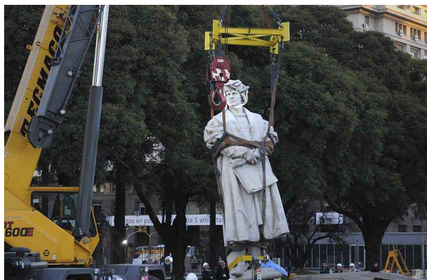
Figura 5 - Içamento do monumento da Plaza Colón em 2013. Crédito: DyN/Archivo
